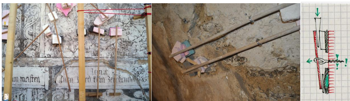
Obrázek 10 Tlakování pákou přes očko. Napravo schematicky zobrazené riziko vytržení očka ze zdi.
