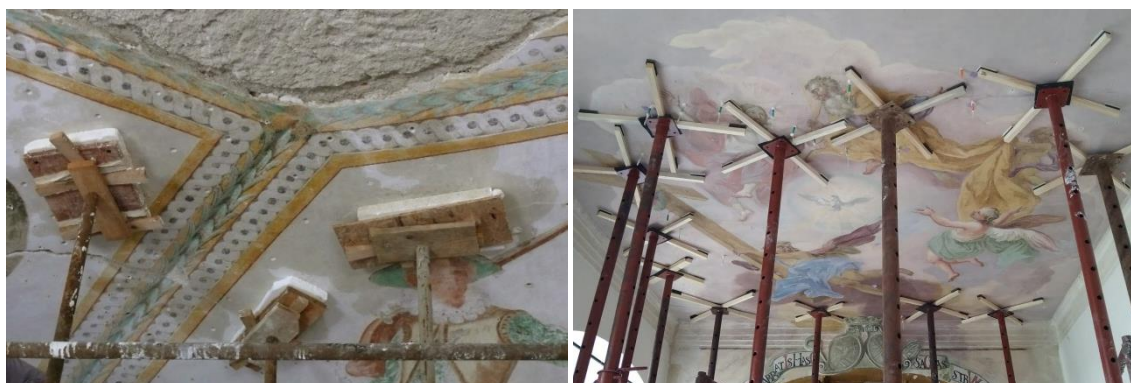
Obrázek 15 Nalevo podložky z extrudovaného polystyrenu a dřevěné desky a klíny. Napravo kříže s gumovými podložkami.
