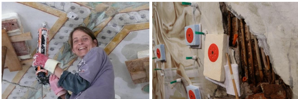
Obrázek 6 Nalevo injektáž pistolí Pointig gun. Napravo osazené zelené katetrovací hadičky pro injektáž stříkačkou.
