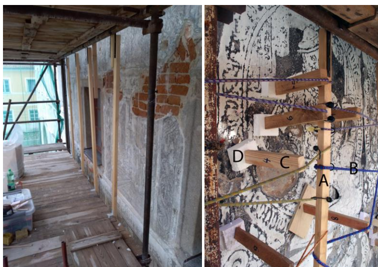
Obrázek 11 Nalevo rošt z latí upevněný na lešení. Napravo tlakování pomocí praků z gumolan natažených na pevný rošt.
