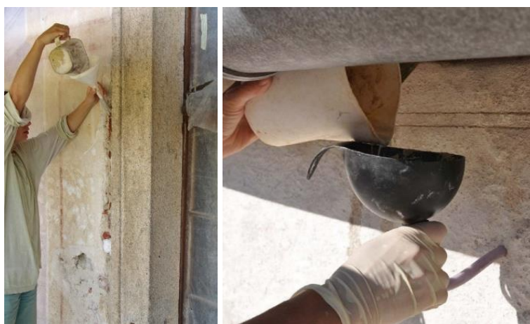
Obrázek 21 Aplikace řídké malty do statické trhliny přes trychtýř s hadičkou
